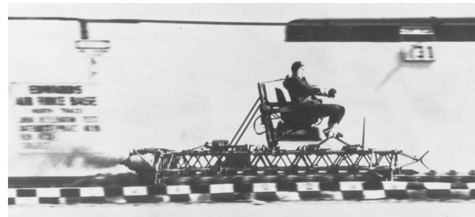
Figur 5a). Rakettslede utviklet og benyttet av Dr. John Paul Stapp for å undersøke menneskets tåleevne ved bråstopp. Foto USAF, public domain.
