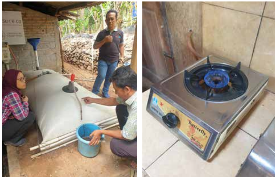
Gassen benyttes i chokoladeproduktionen hos Gunkid. Til venstre ses biogasreaktoren og til højre biogasbrænderen.
